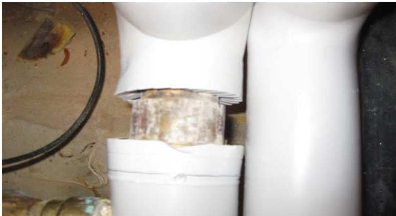
Defekt kontraventil.
