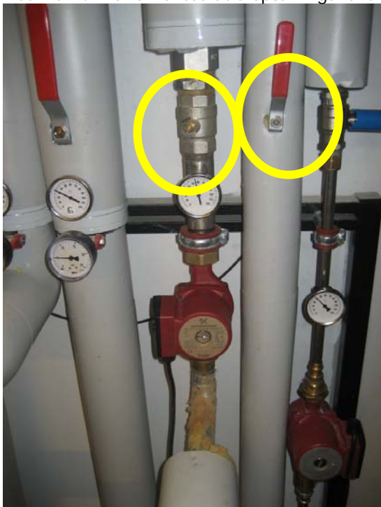
Håndtag kan ikke fastgøres på spindel og ventiler lukker ikke tæt
