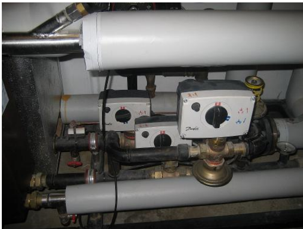
Regulatorer ved varmeveksler – Brugsvand forrest – Varme bagerst
