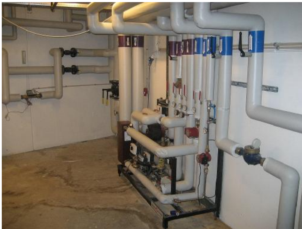
Varmeanlæg og veksler for Fasanhaven
