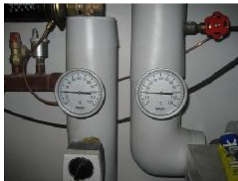
Anlægget er ikke sat i drift – begge termometre viser 20°C og pumpe er slukket
