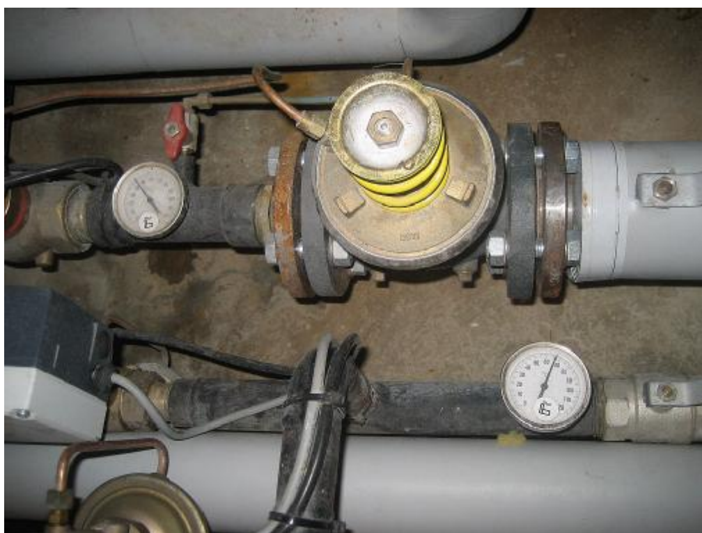
Regulatorer ved varmeveksler – Brugsvand forrest – Varme bagerst
