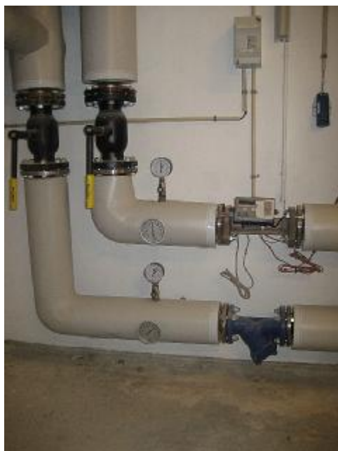
Fjernevarme frem og retur samt varmemåler
