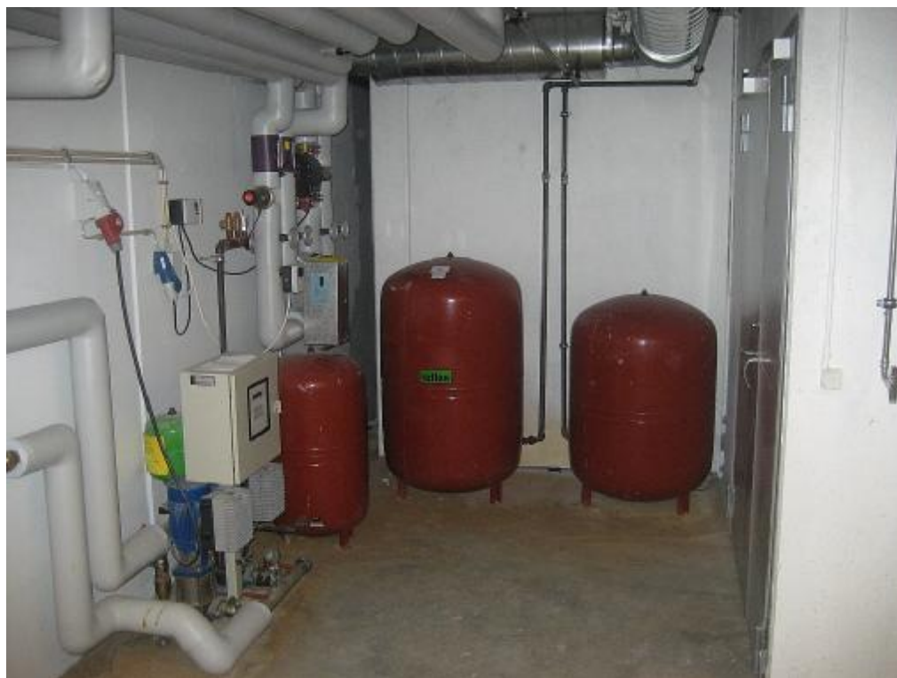
Varmeanlæg og veksler for Rampe – samt de 3 ekspansionsbeholdere
