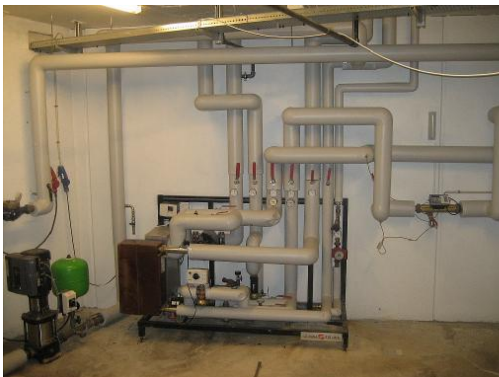
Varmeanlæg og veksler for Porcelænshuset
