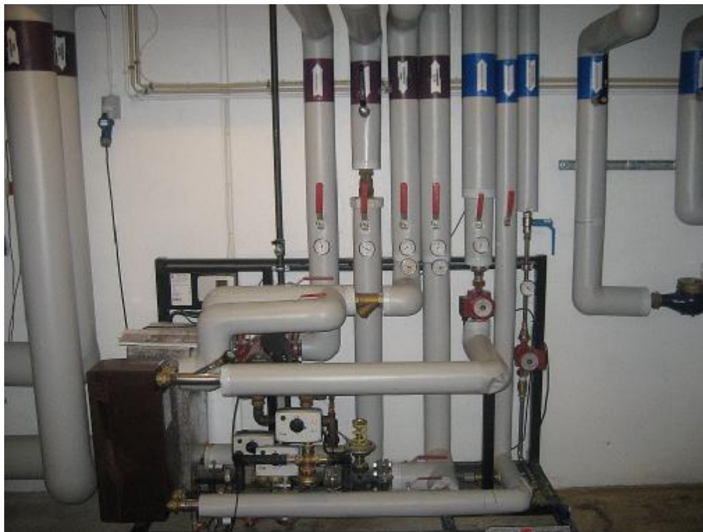
Varmeanlæg og veksler for Fasanhaven
