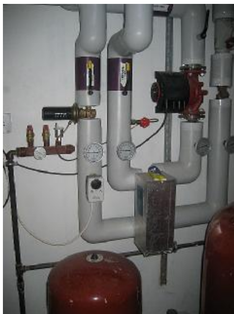
Anlægget er ikke sat i drift – begge termometre viser 20°C og pumpe er slukket
