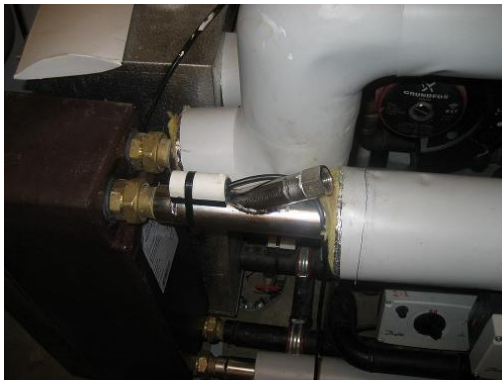
Dykrørsføler nedtaget – ny påspændingsføler
