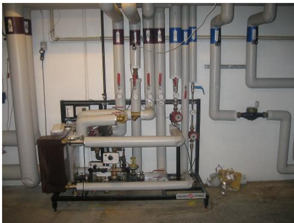
Foto optaget 12.5.2009 - efter ombygning
