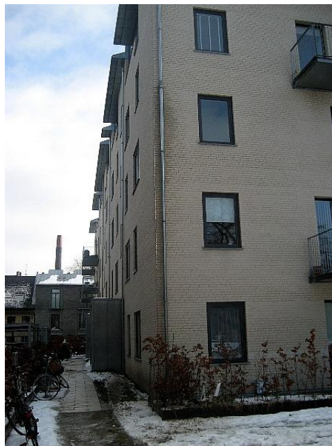
Samme hjørne, set fra park (vestfacade mod park)
