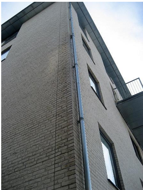
Opfugtning af murværk ved tilslutning af afløb fra altaner til nedløbsrør (nordfacade)
