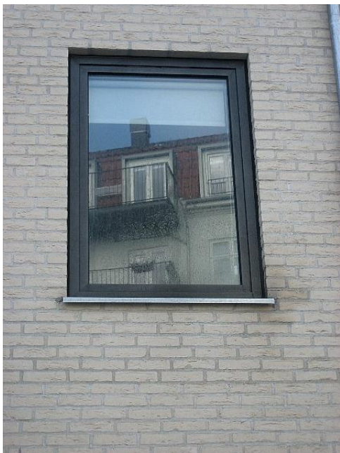
Tydelige spor af opsprøjt på vindue og nærliggende murværk. (nordfacade)
