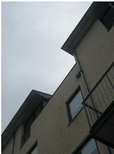
Dryp fra tagskæg ved indskæring i tagflade (kraftige dryp fra begge de lodrette sider)
