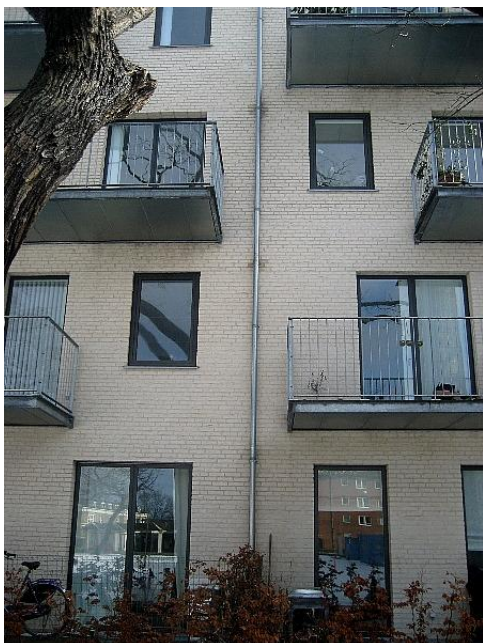
Opfugtning af murværk ved tilslutning af afløb fra altaner til nedløbsrør (vestafacade mod park)
