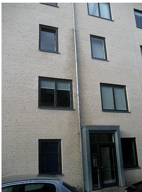
Opfugtning af murværk ved tilslutning af afløb fra altaner til nedløbsrør (østfacade udfor 4C)
