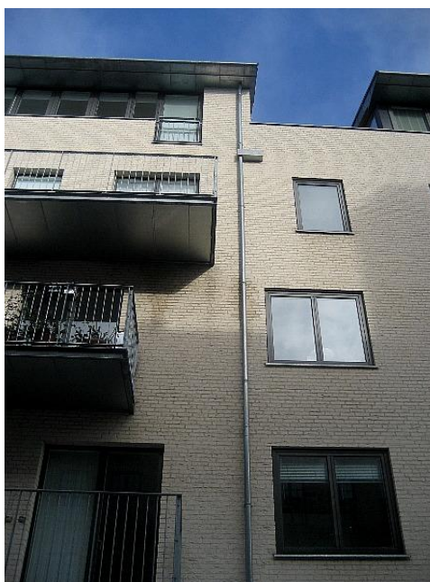
Opfugtning af murværk under terrasse og ved tilslutning af afløb fra altaner til nedløbsrør (sydfacade)
