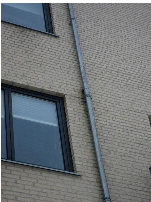
Opfugtning af murværk ved tilslutning af afløb fra altaner til nedløbsrør
