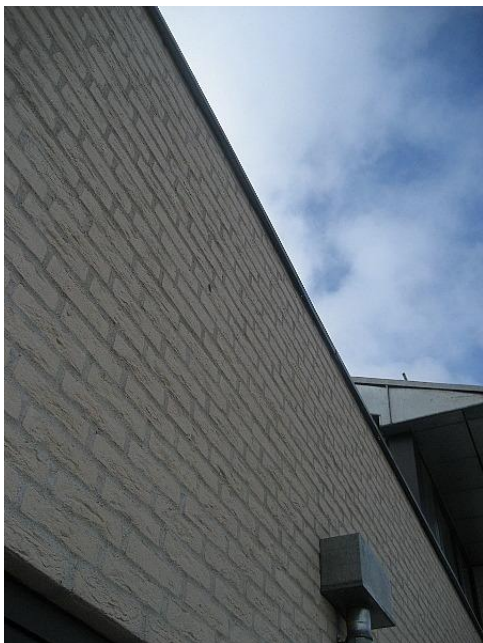
Inddækning af murkrone ved indeliggende terrasse. Afvanding sker tæt ved murværk (nordfacade)
