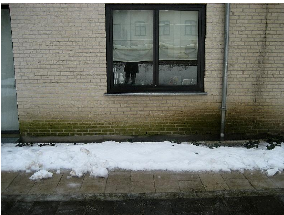
Opfugtning af murværk ved sokkel (nordfacade)
