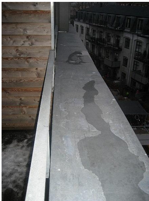
Inddækning af murkrone. Afvanding sker udaf mod underliggende murværk
