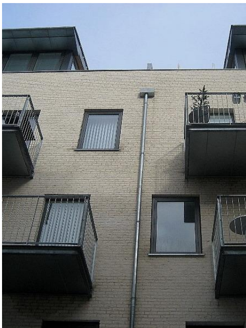
Opfugtning af murværk under terrasse og ved tilslutning af afløb fra altaner til nedløbsrør (sydfacade i gård)
