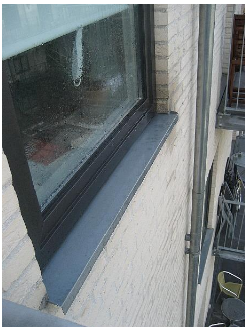
Dryp fra inddækning rammer underliggende sålbænk. Tydelige spor af opsprøjt på vindue og nærliggende murværk. Sålbænk har ydermere bagfald.
