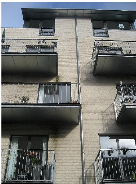
Opfugtning af murværk under terrasse (sydfacade i gård)
