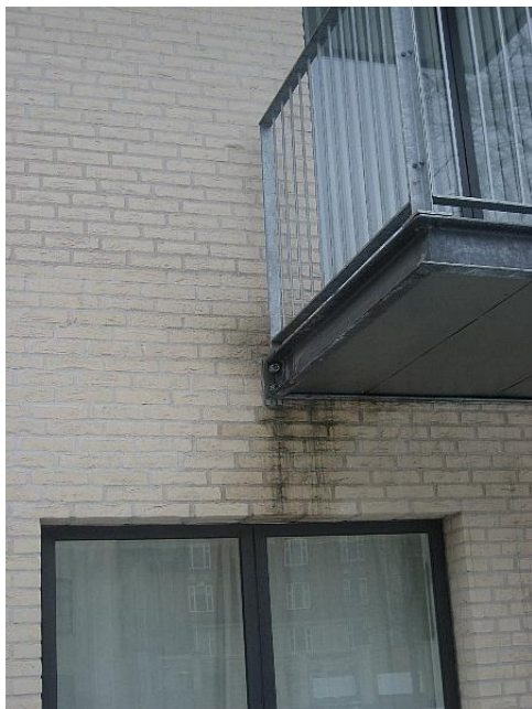
Opfugtning af mur under terrasse (nordfacade mod gård)
